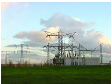
Fig. 2.4f: Stijg- en daalpunten vormen forse elementen in het landschap. Ze markeren de overgangen van bovengrondse delen en verkabelde delen van het tracé een belangrijk aspect van de lijn op tracéniveau.
