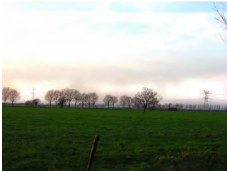
Fig. 2.4g: Verschillende masttypen, in dit geval een steunmast en een hoekmast, beïnvloeden het karakter van de lijn als een eenheid
