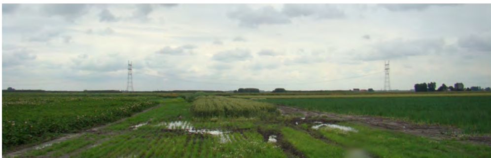
Fig. 3.3an: Het zeer open droogmakerijenlandschap ten oosten van Benthuizen met de bestaande 150 kV lijn. Dit landschapsbeeld zal worden vervangen door de beslotenheid van het recreatieve groengebied Bentwoud.
