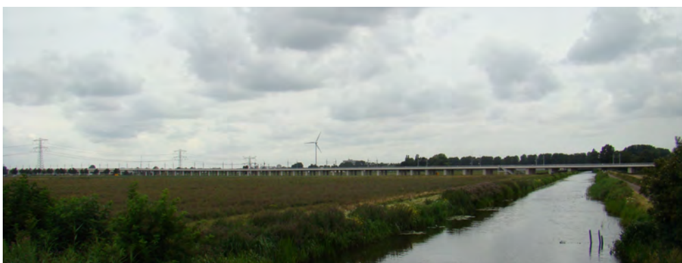
Fig. 3.3ar: De boezemvaart van de Klappolder met de bijbehorende kades gezien vanaf de Nieuwe Hoefweg wordt in de verte gekruist door de nieuwe HSL op een markant hoog kunstwerk. Links in beeld de bestaande 380 kV lijn in bundeling met de A12 en midden in beeld de windmolen ter plaatse van het huidige 150 kV station. Het huidige beeld zal plaatsmaken voor verdere uitbreiding van het bedrijventerrein dat nu aan de westzijde van de HSL in ontwikkeling is.
