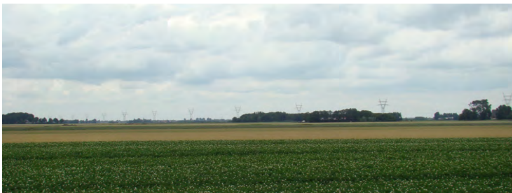
Fig. 3.3ap: Het zeer open droogmakerijenlandschap bij Moerkapelle dat in een strak ritme door de bestaande 150 kV lijn wordt gepasseerd.
